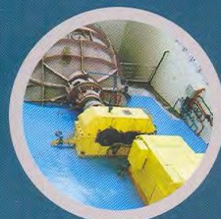
水机齿轮箱 (水电水泵用)
